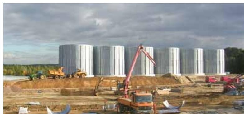
Die **HAMCO MULTI-PLATE** Bauweise ermöglicht auch die Herstellung von **Wasserbehältern** bis zu 30,54m Durchmesser und 6,10m Höhe. Diese sind von der Ausführung wie die Kiessilos, erhalten jedoch eine Abdichtung aus dauerelastischem Dichtungsband, das während der Montage in alle Längs- und Quernähte eingelegt wird. Außerdem sind keine aussteifenden Winkelstahlprofile und keine Fundamente erforderlich.
