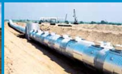
**Hamco Multi-Plate** Stahlfertigteile beschreiben einzelne gewellte, gebogene und feuerverzinkte Stahlplatten verschiedener Abmessungen. Sie werden auf der Baustelle zu geschlossenen oder offenen Profilen zusammenschraubt und dienen als Abzugstunnel unter Halden und Silos oder als Wasserbehälter.
