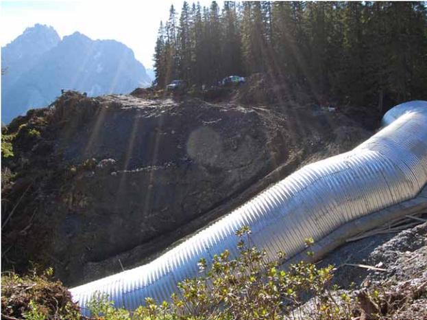
Kreisbogenprofil unter Gefälle mit diversen horizontalen und vertikalen Richtungswechseln (Hamco MP200)
