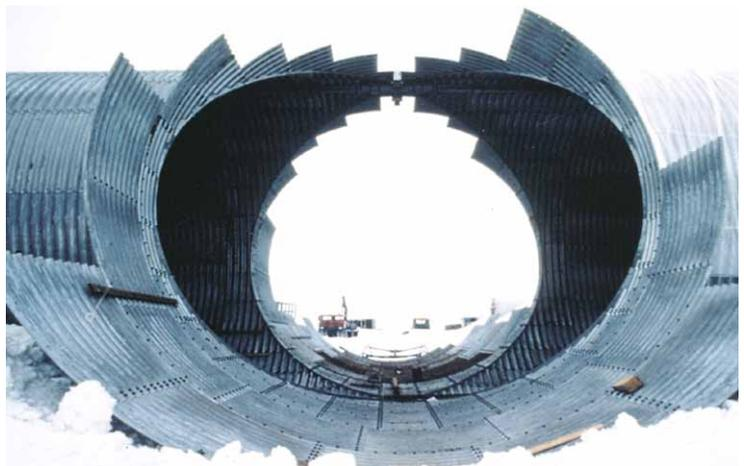
Durchdringung von zwei gleich großen Profilquerschnitten (Hamco MP 200)
