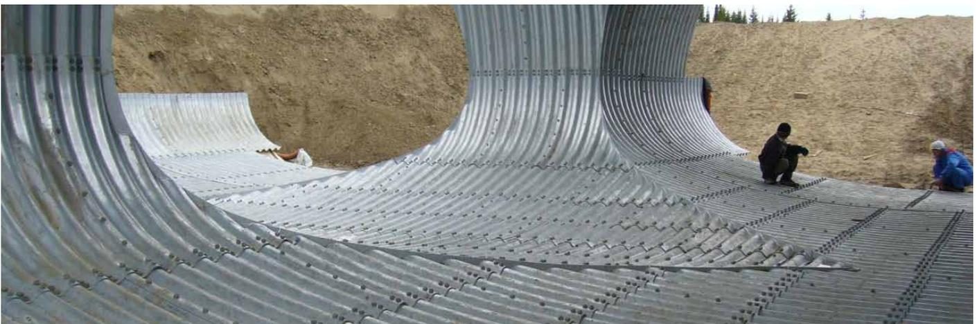
Bild oben – Verbindung von zwei parallel verlaufenden Maulprofilen mit einem Maulprofil gleicher Größe (Hamco MP200)
