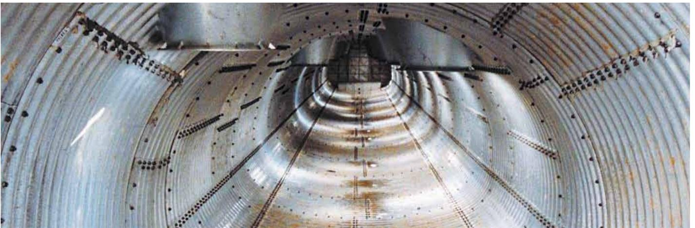
Vertikales Knickstück und eingeschweißte Trichter (Hamco MP200)
