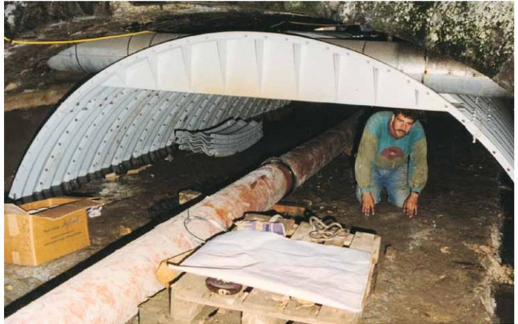
Sonderkonstruktion für bauseits querende Leitung (Hamco LP 2-Flansch)
