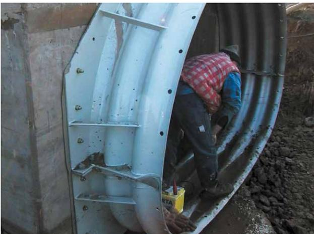
Anschlussflansch an Betonbauwerk
