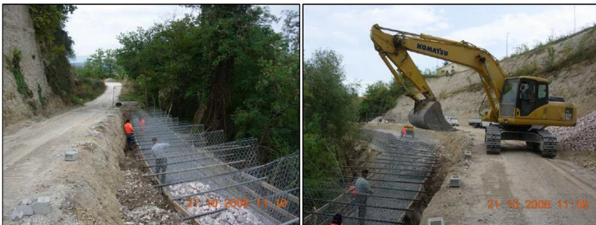
11. ábra – Gabion kosarak feltöltése
