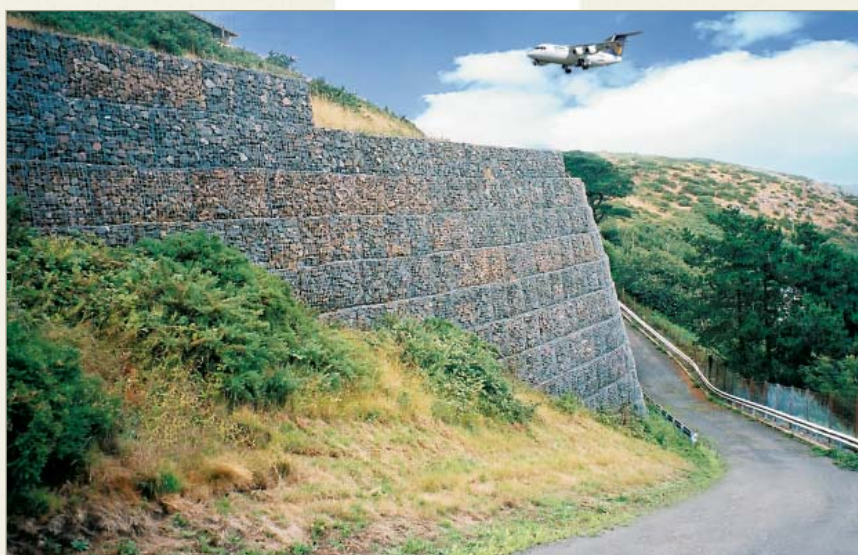
1968-ban épült Jersey szigeti repülőtér megtámasztására
