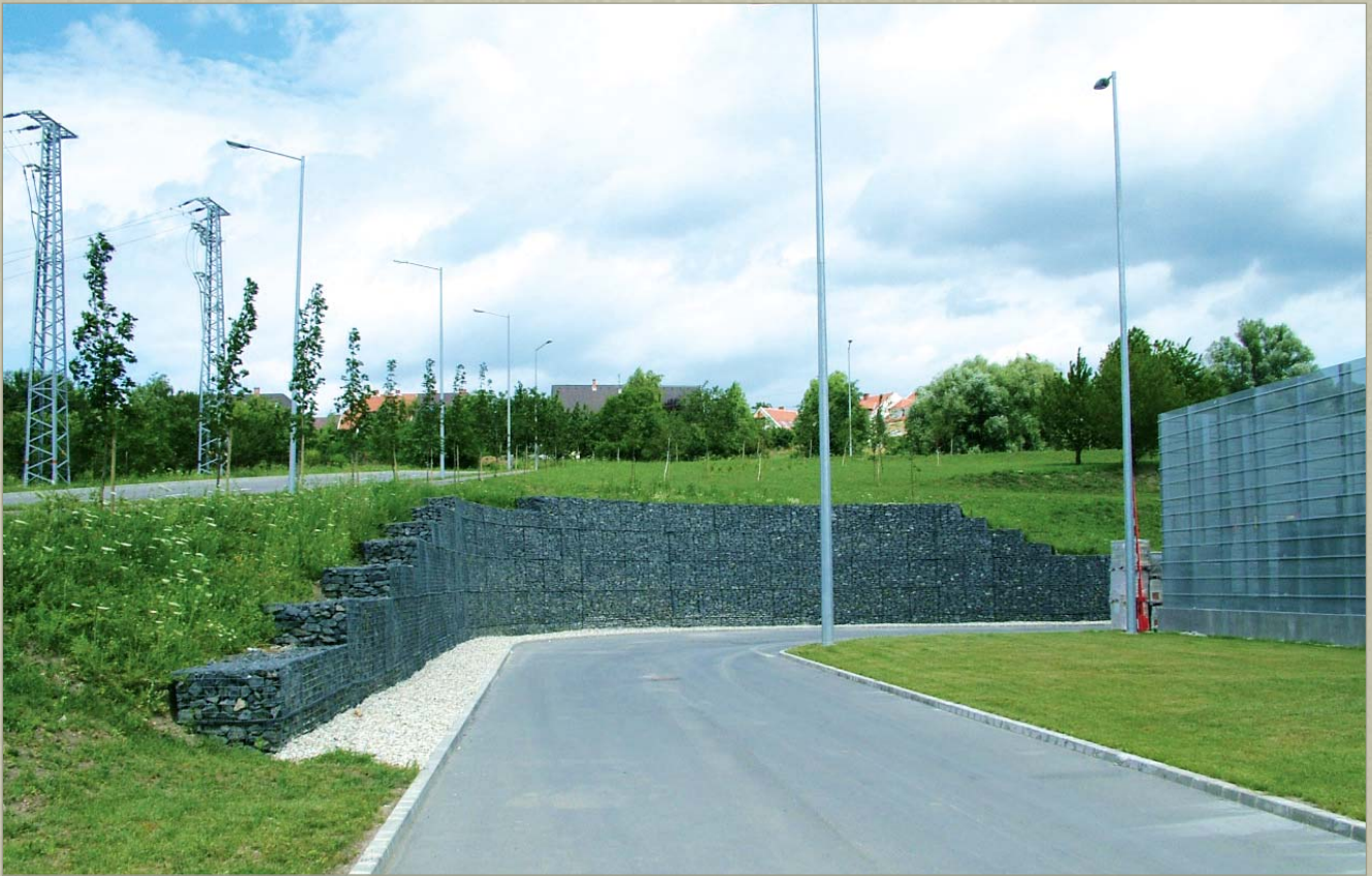
A Soproni Baumax áruház bazaltból épült támfala, 2007
