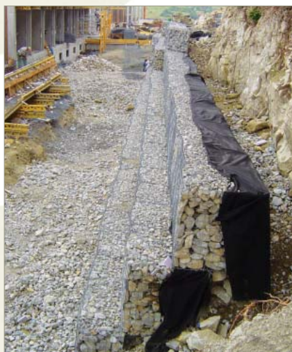
Támfal építése. Egerszalók völgye, Magyarország, 2008
