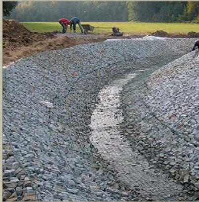
Csatorna burkolás, A4 Krzywa, Lengyelország :: épült 2005-ben
