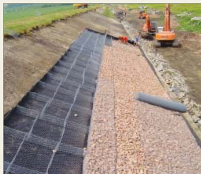
Víztározó részűburkolat építése. Zámoly, Magyarország, 2008
